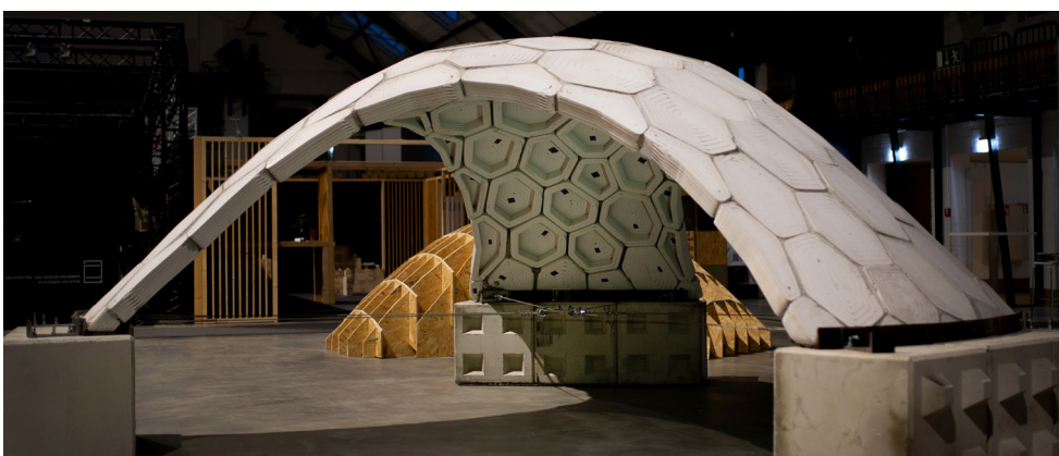
Figure 7 Hexastone, Design for disassembly, Technische Hochschule Lübeck, Vertico, Sika - Annex A, Case study 005, Image courtesy of Technische Hochschule Lübeck
